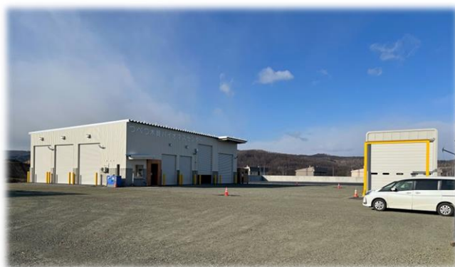
つべつ木質バイオマスセンター 建設中
