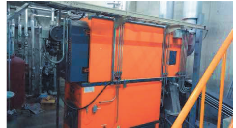
木質バイオマスボイラー
